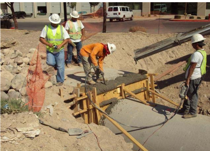
CAMU: Manhole #8, concrete collar.,
